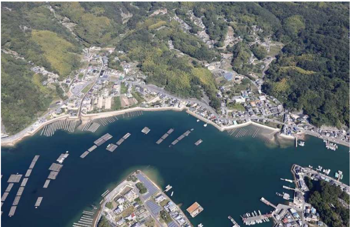
港湾海岸保全施設整備事業 鹿川港海岸大柿地区（江田島市大柿町）
