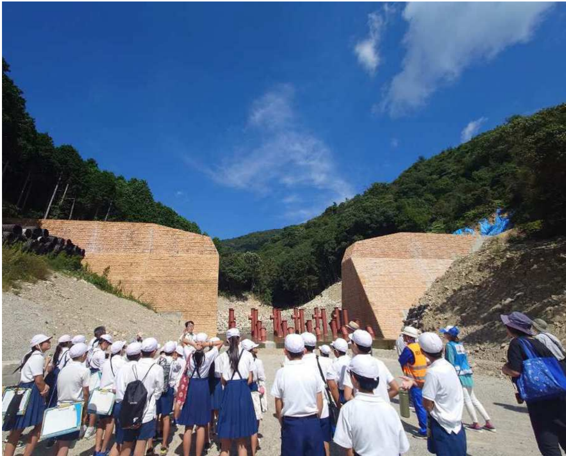
地元自主防災会関係者と小学生へ向けた砂防出前講座での現場見学会の様子 (呉市・光明寺川砂防堰堤)
