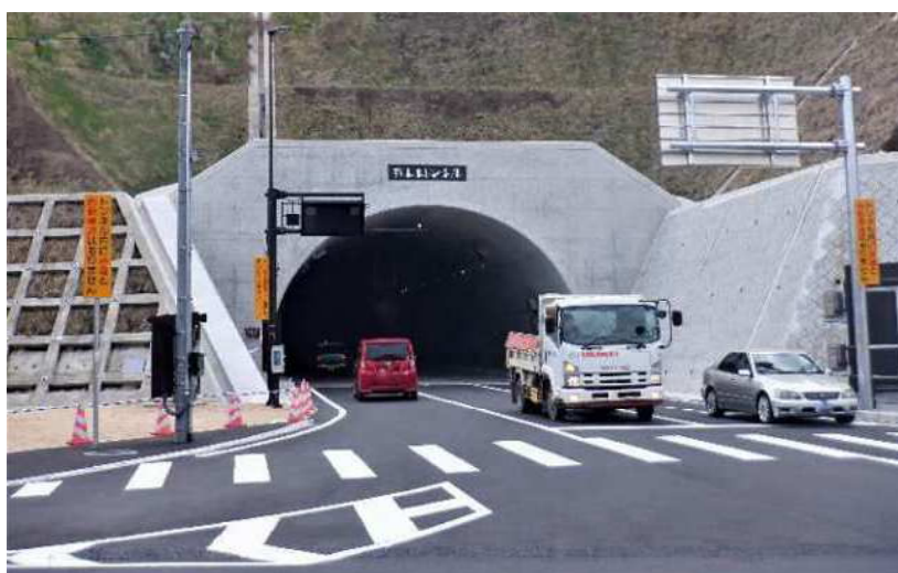
供用を開始した鞆未来トンネル
