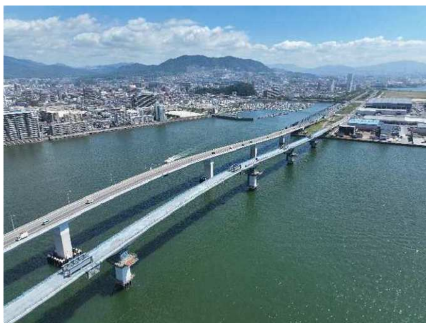
広島はつかいち大橋上部工の架設
