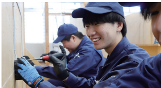
電気工事実習
