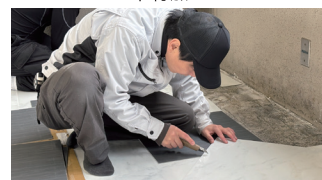
内装実習(床タイル貼り)
