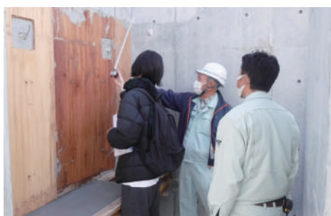
工事監修の様子
