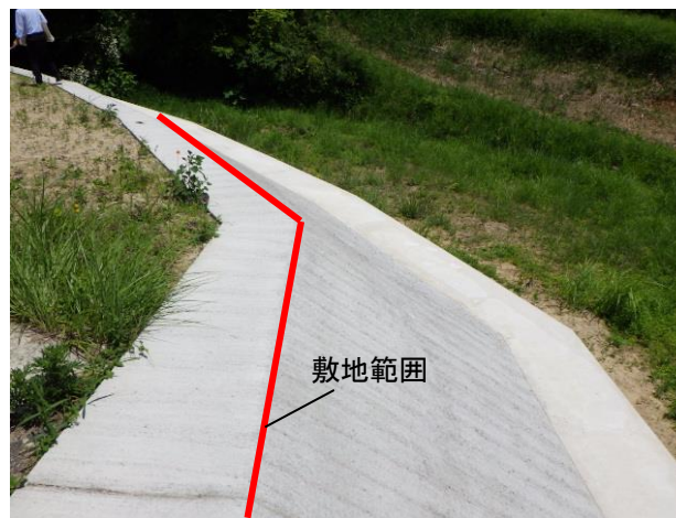
⑤地点擁壁の写真
