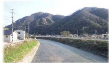
【河川堆積土等の除去】
