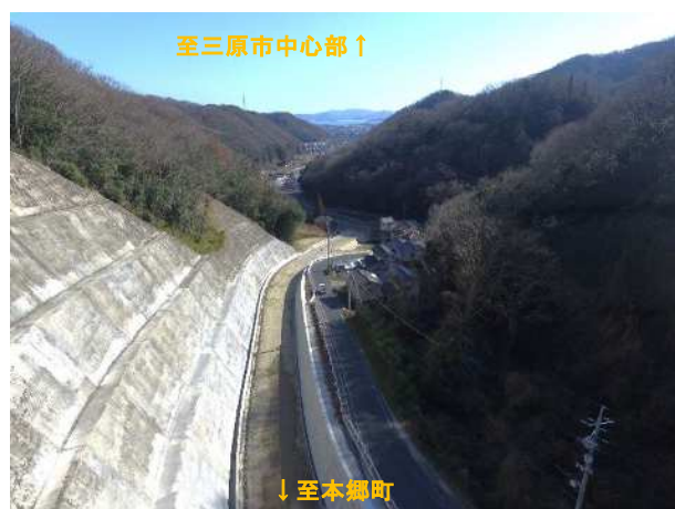
起点側（三原側）
