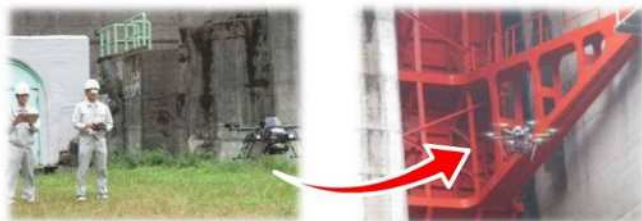
【ドローンを活用した施設点検】
