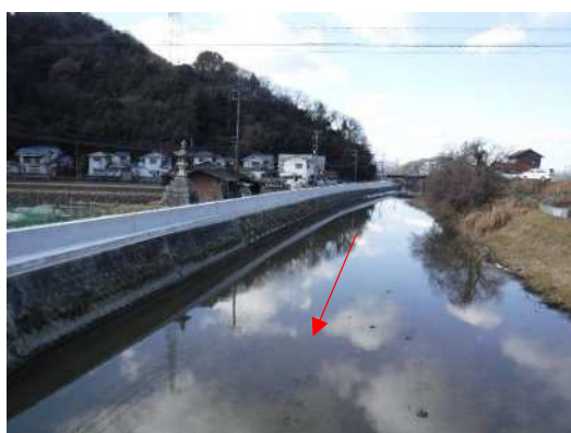
護岸の嵩上げ（天井川：三原市明神）
