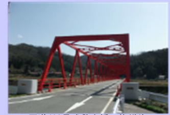
国道433号式敷大橋 修繕後
