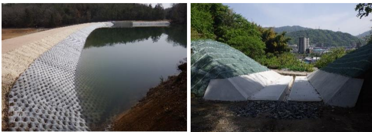
農業用ため池の防災工事
