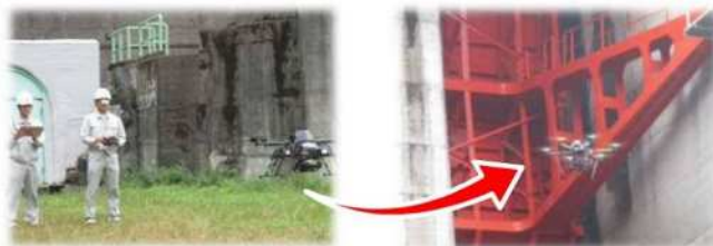
【ドローンを活用した施設点検】
