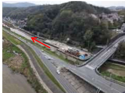
用水管渠敷設工事
