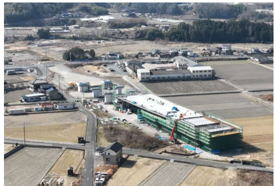
施工状況（福山市駅家町）
