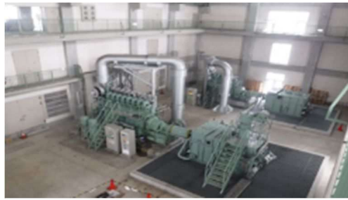
ポンプ増設工事（手城川排水機場内）
