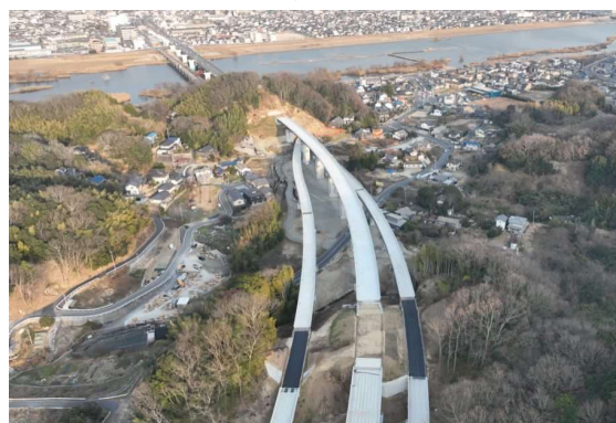
施工状況（草戸町周辺）
