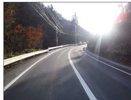
終点側（トンネル東側）
