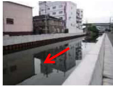
中流域工事（福山市引野町）
