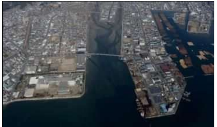
尾道糸崎港（機織地区）
