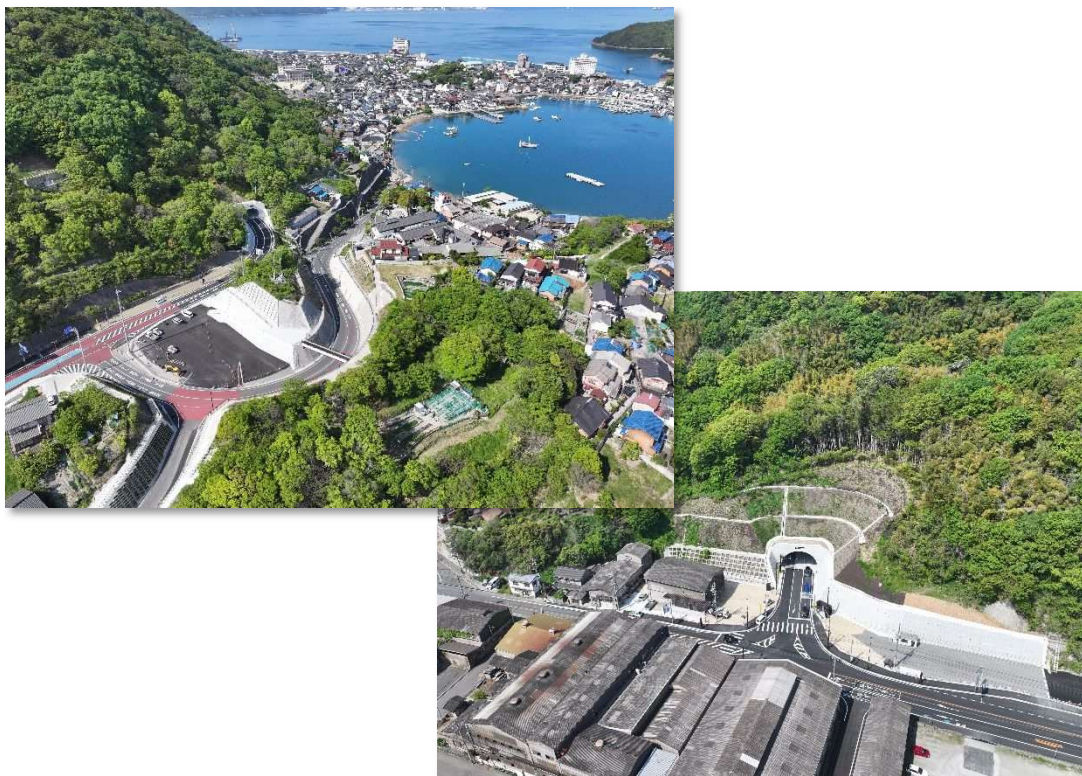
鞆松永線バイパス（福山市鞆町）
