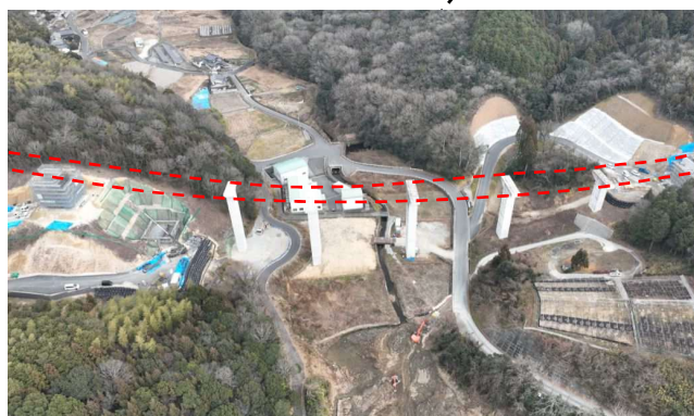
施工状況（瀬戸町周辺）
