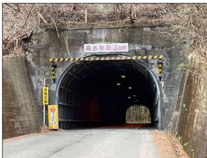
長者原トンネル
