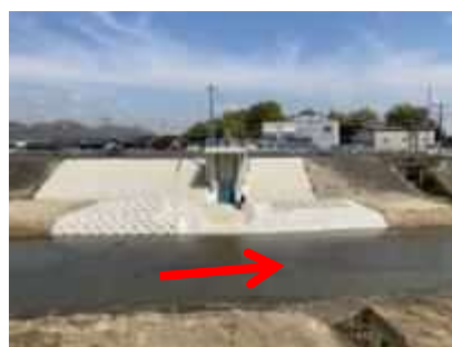
吐出樋門（瀬戸川）
