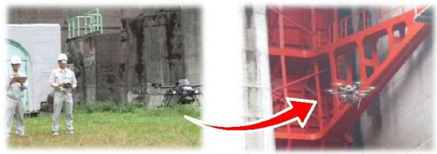
ドローンを活用した施設点検
