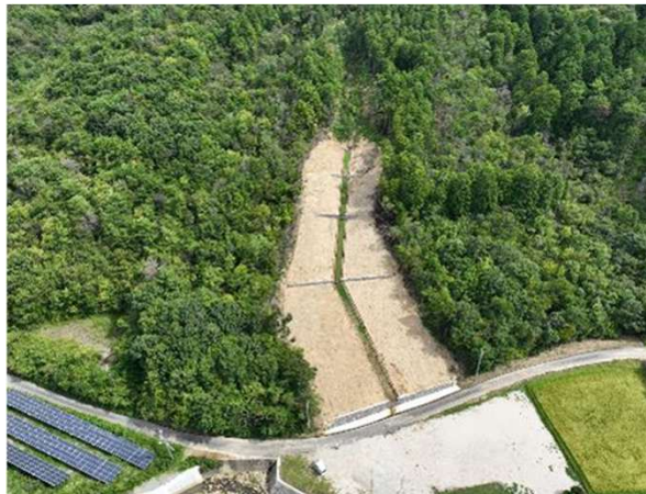
山腹工(東広島市)
