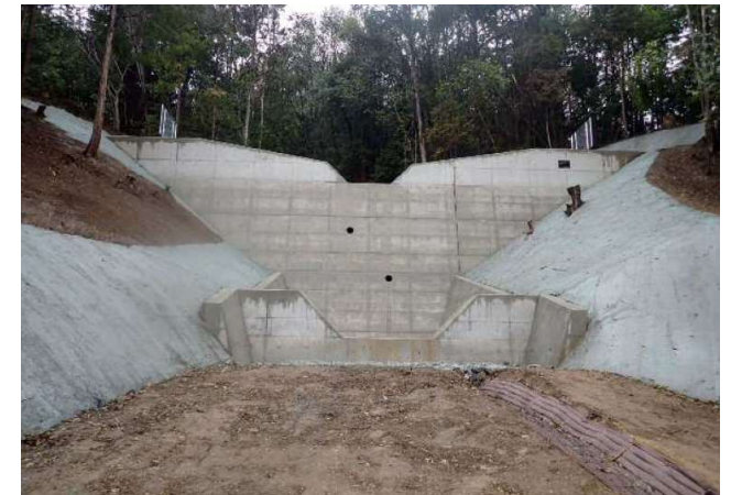
溪間工(安芸高田市)
