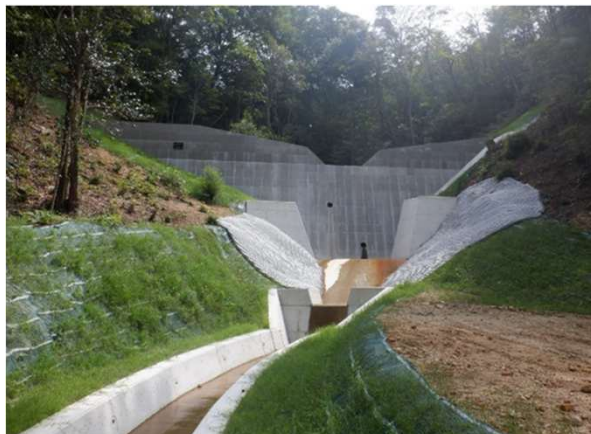
溪間工(谷止工)
