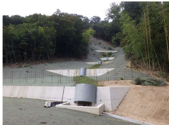
山腹工(土留工)
