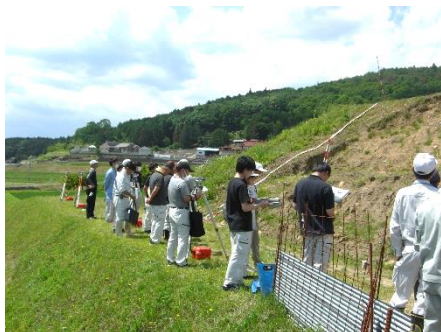
（被災状況の確認）
