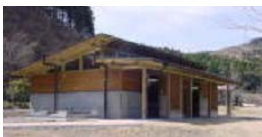
多目的トイレ
