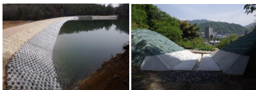
農業用ため池の防災工事
