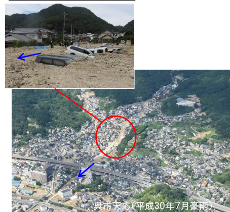
土砂・洪水氾濫の発生状況
