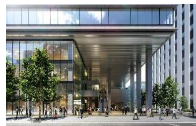
高層棟低層部
