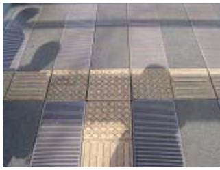
視覚障害者誘導ブロック LED内蔵点字誘導ブロック
