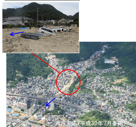
土砂・洪水氾濫の発生状況
