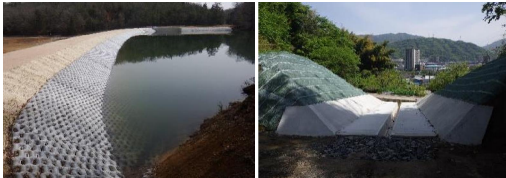
農業用ため池の防災工事
