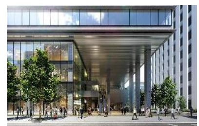
高層棟低層部
