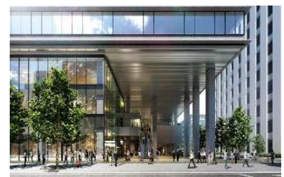
高層棟低層部
