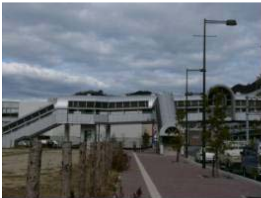
屋根付きの立体横断施設で JR 呉駅から雨に濡れることなく目的地へ移動することができます。
