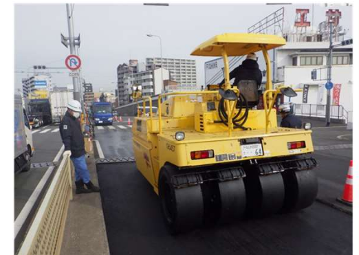
鋼床版上でのFRバイNDERを用いた混合物の施工
