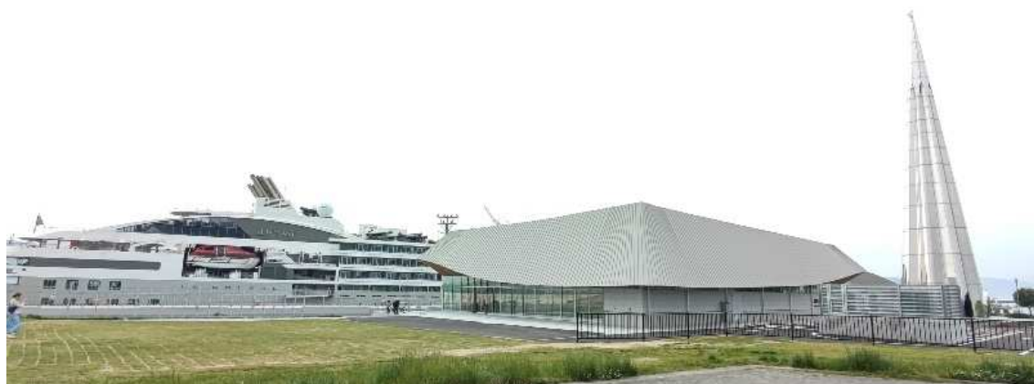
図 1.1.8 広島港宇品地区クルーズターミナル (2024(令和6)年3月供用)
