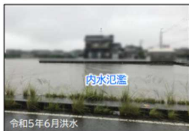
内水により家屋周辺が浸水
