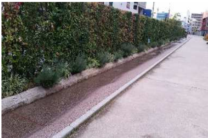
≡ せせらぎ水路 ≡
