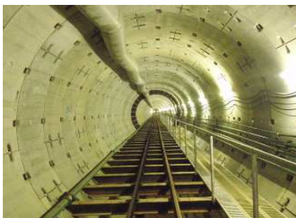
○ シールド管渠 直径φ3.75m
