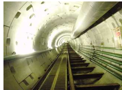
○ シールド管渠 直径φ2.20m
