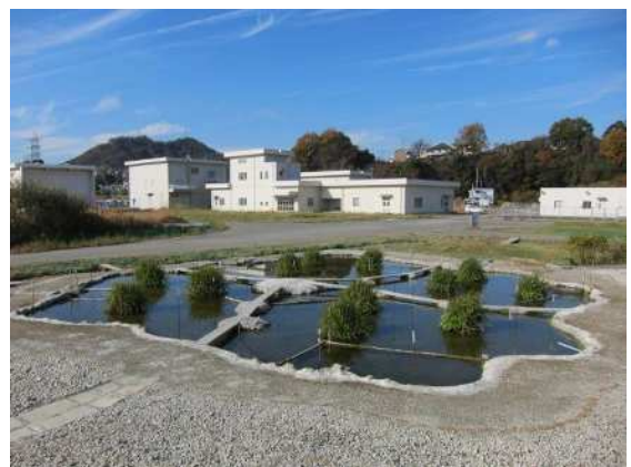
東部浄化センタービオトープ
