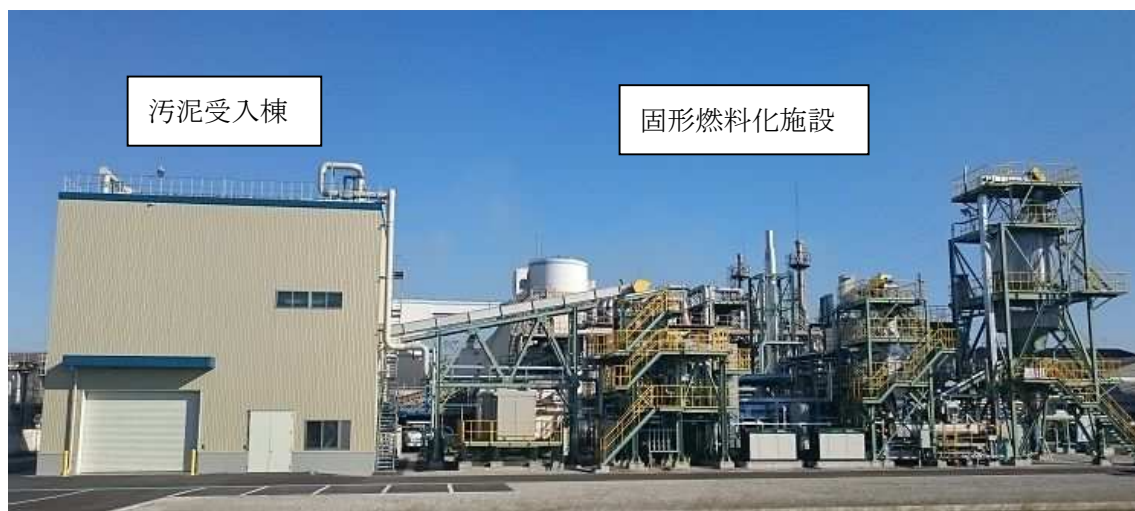
固形燃料化施設全景（H29.1撮影）
