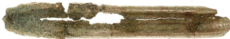
修理前の状況
