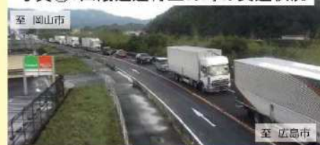
国道2号(三原市長谷地先付近)
