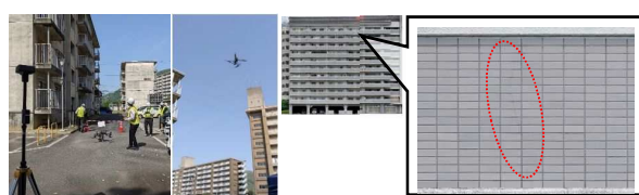
ドローン等（オルソ画像）を活用した外壁の劣化状況調査の試行(R4.4)
