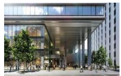
高層棟低層部
