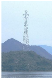
図1 日本一の鉄塔
