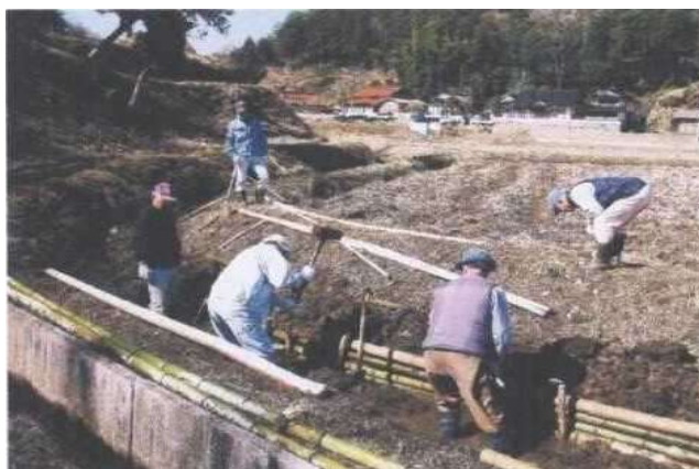
保護活動の一環として水路改修を実施
