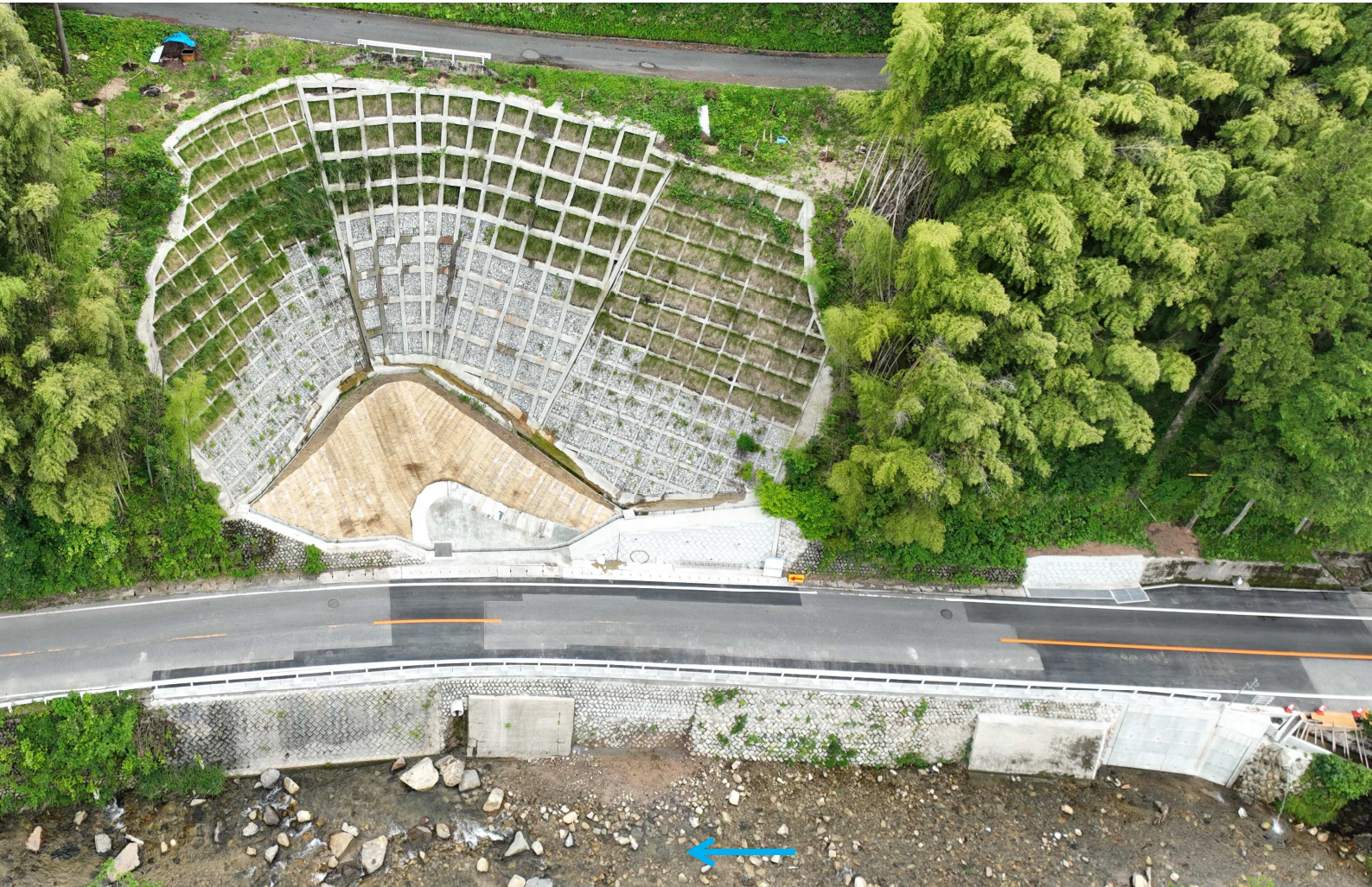
令和 2 年災害 第148号 一般国道433号 北広島町戸谷 豊平交通前 復旧後 令和 5 年 6 月完成
