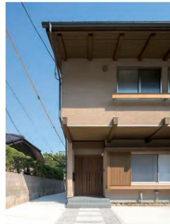
北側のオーバーハングには150×420×8000mmの材を使用。大きく張り出した構造材は力強い印象。
