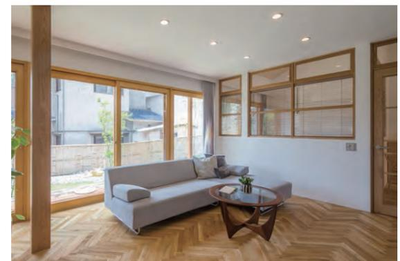
リビングを見る。左の柱は一度切られていたものを、傾きを修整し新しく取替えられている。
