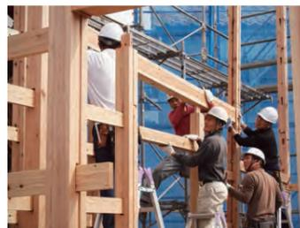
建前の様子。手刻みされた材料はクレーンなどは使わず、1本ずつ大工によって組み立てられる。
