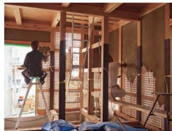
土壁塗りの様子。木小舞の下地に、土とワラを混ぜさせた壁土を塗っていく。
