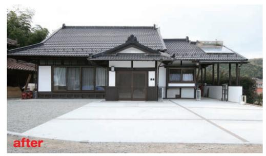
木の趣ある玄関へ再生するために、外壁のサイディングを撤去し、杉板の壁と漆喰仕上げにしている。
