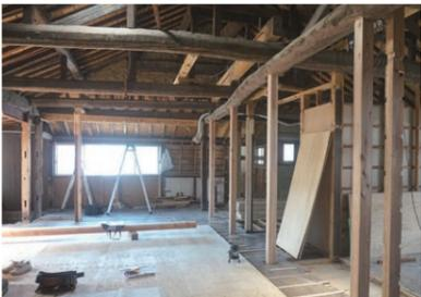
昭和期の無理な改修で崩れた架構を整え直した。大梁の下に柱を設置し耐力壁をバランスよく配置。
