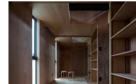
将来、三部屋にできるよう出入口、棚、吹抜を三つずつ設け、壁となる部分には構造体を入れている。
