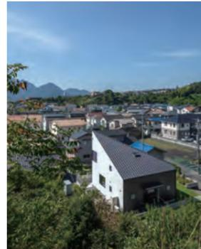
光を取込む南東側に向かって高くなっていく外観形状。日中光を受ける面を白、逆側を黒の外壁で構成している。
