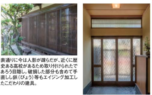
表通りに今は人影が疎らだが、近くに歴史ある高校があるため取り付けられたであろう目隠し。破損した部分も含めて手直しし鉄(びょう)等もエイジング加工したこだわりの建具。
