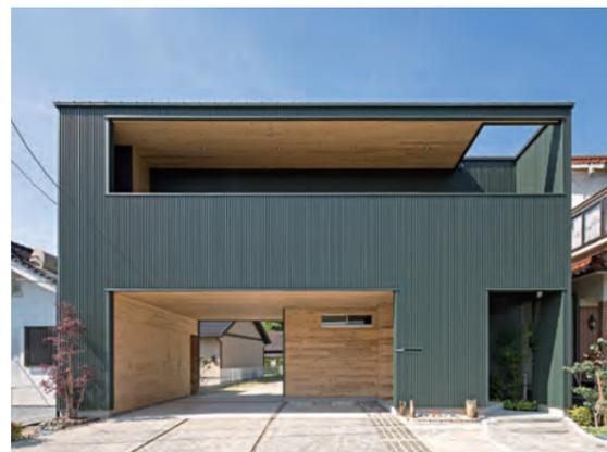
2階内部が通りから見えないような手摺高と、軒裏の木目が際立つガルバリウム鋼板の外壁。
