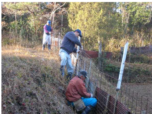
獣害防護柵の設置作業
