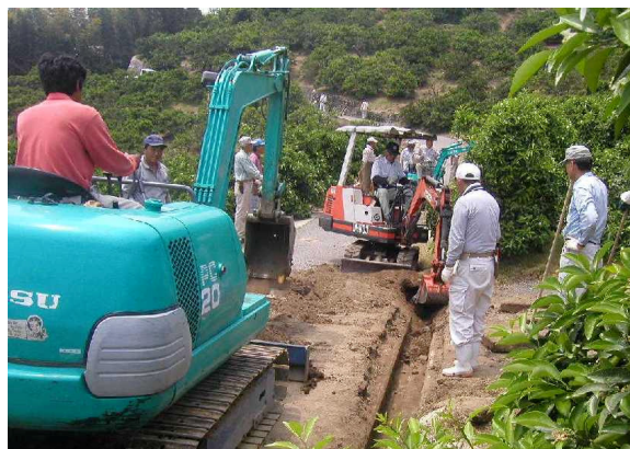
水路土砂上げ作業
