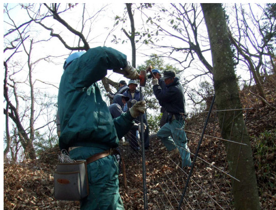
『イノシシ防護柵』設置作業
