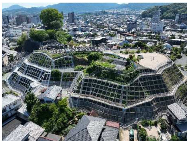
急傾斜地崩壊対策事業 篠尾地区 （廿日市市天神） 令和6年度完成
