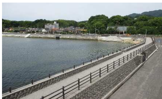
地御前漁港海岸（1 工区）
