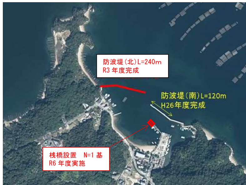
巖島港整備事業（杉之浦地区）
