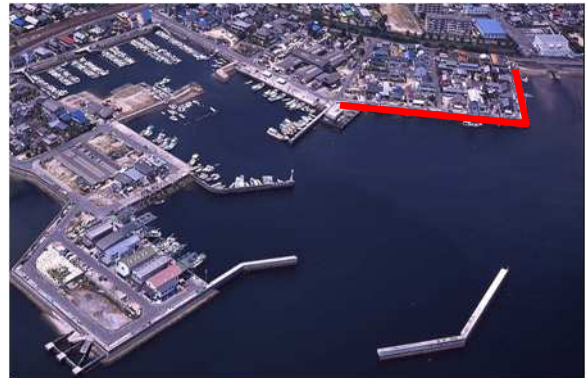
地御前漁港海岸（2工区）
