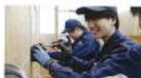
電気工事実習
