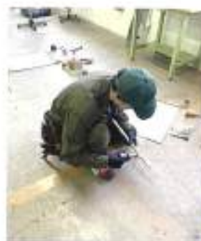
合成樹脂管工事
