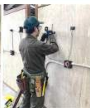
ケーブル工事
