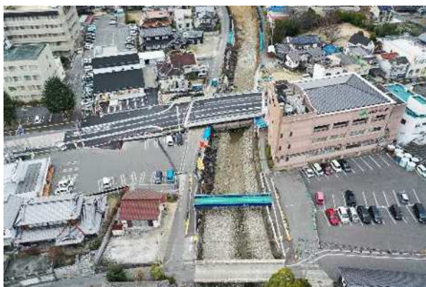
三津大川 新興橋復旧工事完了
