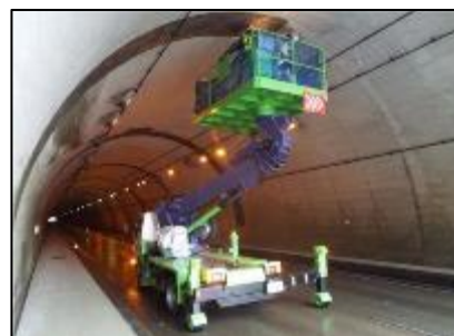
トンネル点検
