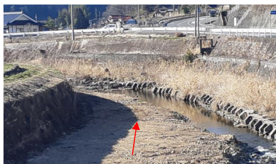
堆積土除去後
