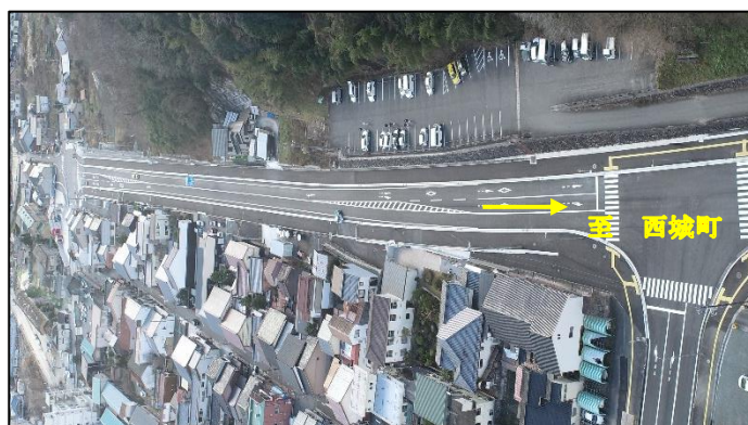
R4.12 に供用開始した 2 工区 1 期工事 (L=400m)
