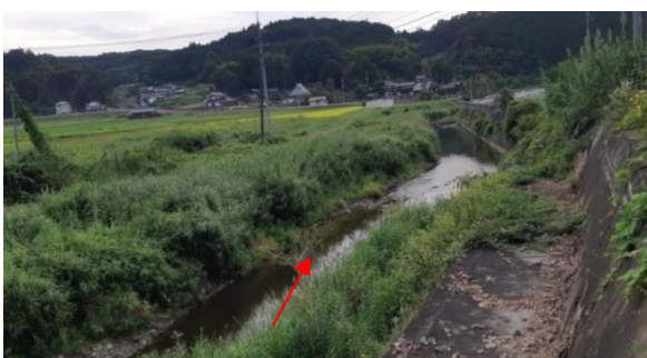
堆積土除去前
