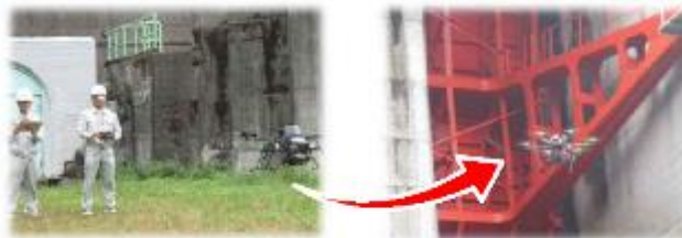
ドローンを活用した施設点検
