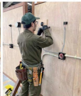
ケーブル工事
