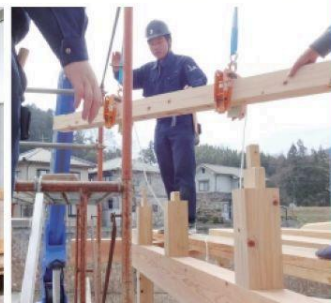
模擬家屋棟上げ実習
