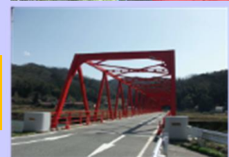
国道433号式敷大橋 修繕後
