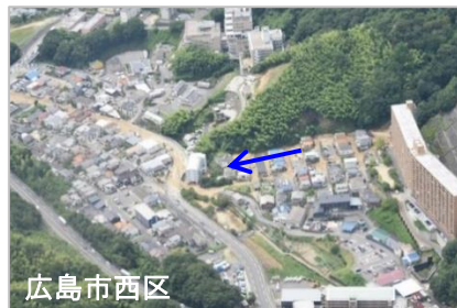
令和3年8月豪雨災害の被災状況
