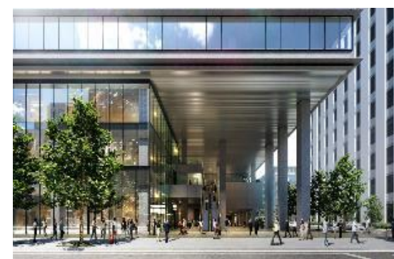
高層棟低層部
