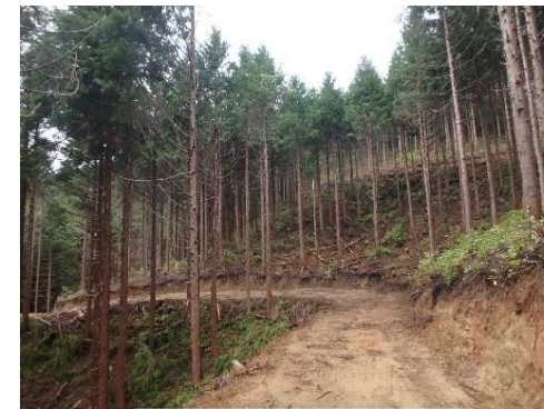
森林作業道開設
