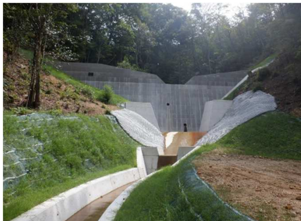
溪間工(谷止工)
