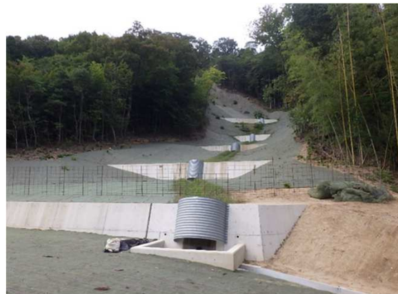
山腹工(土留工)
