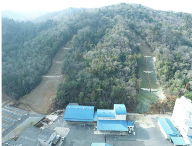
山腹工(三原市)
