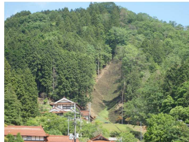
山腹工(安芸高田市)
