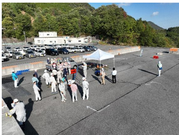
仮置場の設置
