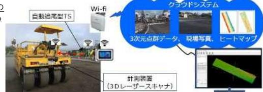
3Dレーザースキャナを重機に搭載し、路床や路盤の出来形点群データを取得。現場でリアルタイムにデータを処理後、設計データと比較して面管理を行う。
